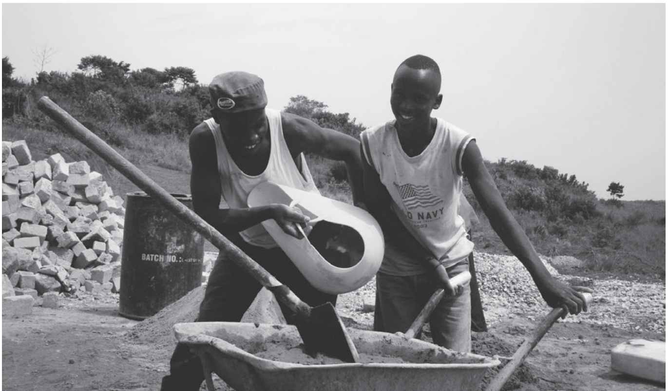
Bauarbeiter in Uganda
